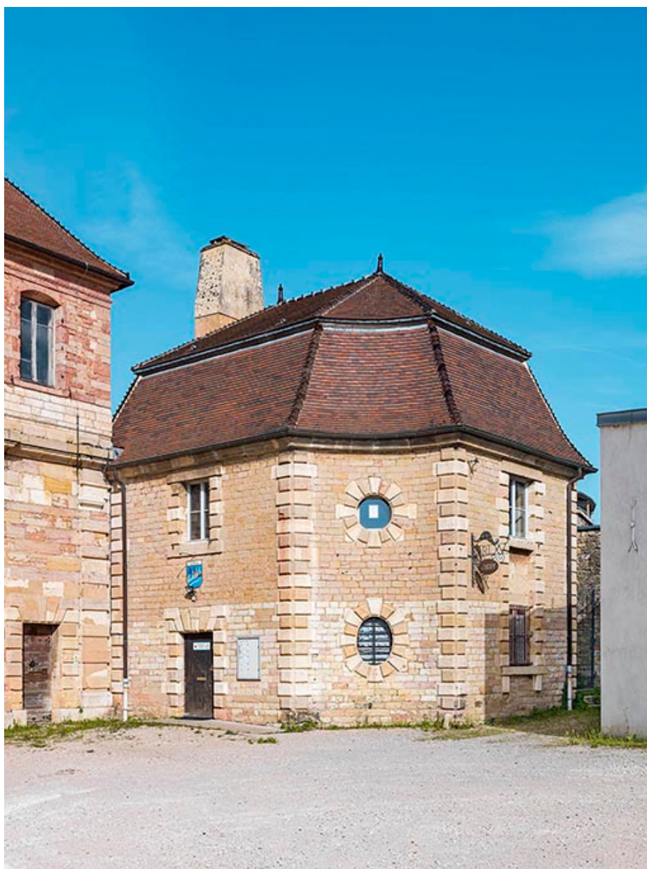
Détail du pavillon est.
