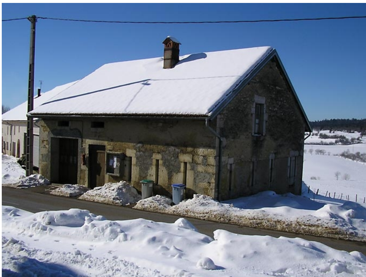
Fromagerie située au lieu-dit Les Bez.
