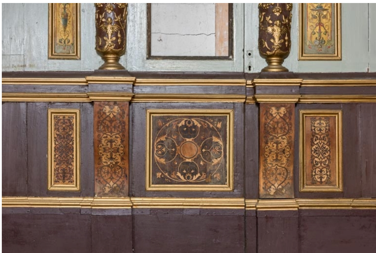
Foyer : lambris à soubassement marqueté.
