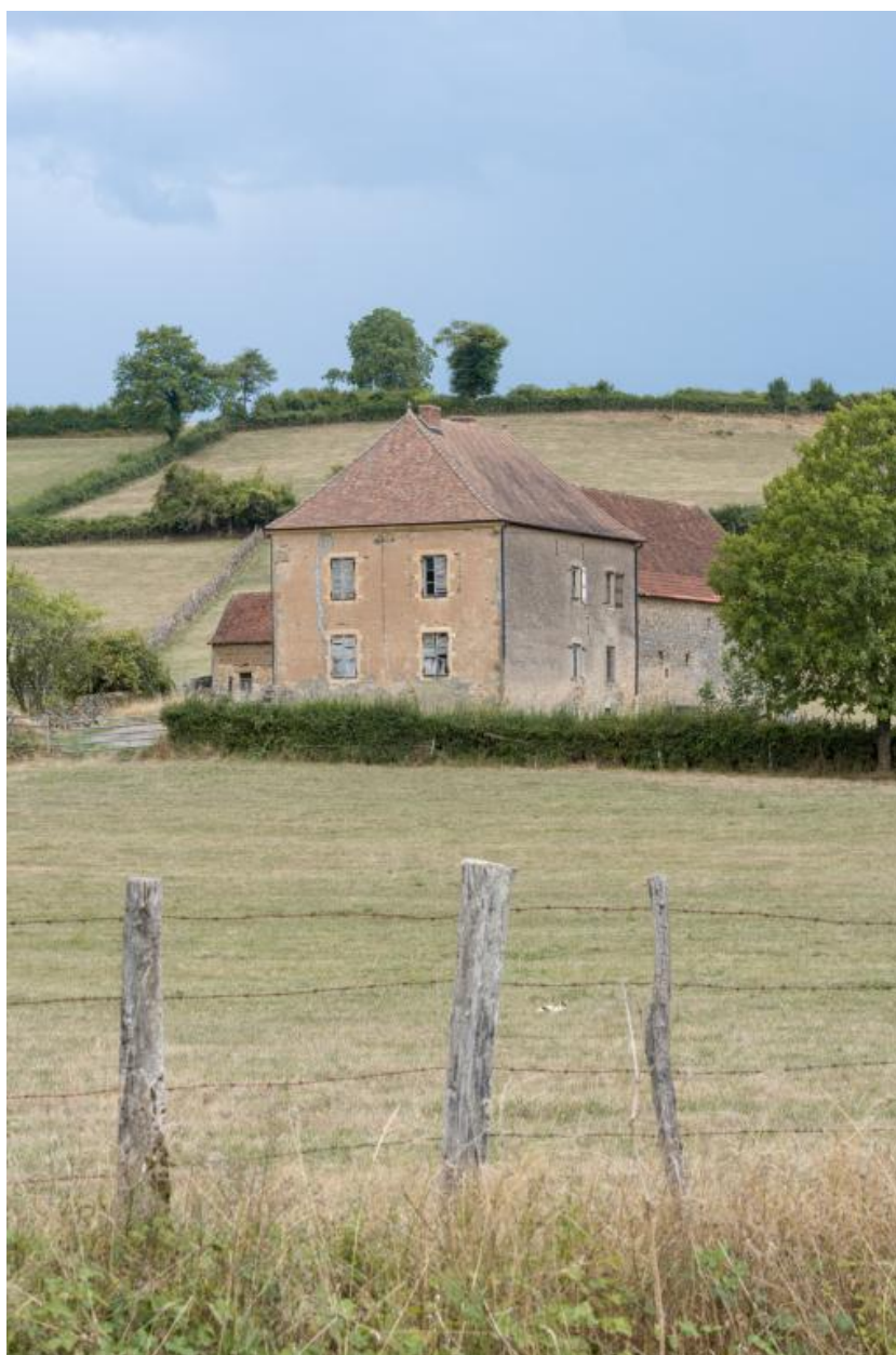
Vue de la ferme au nord-est
