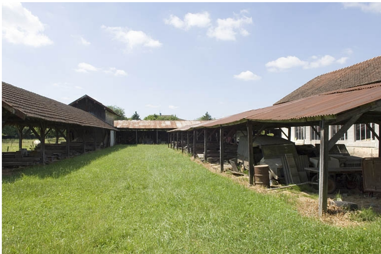
Entrepôts industriels sud.
