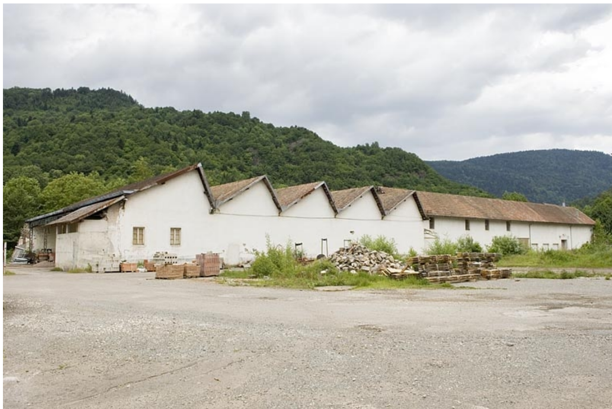
Atelier de fabrication (boulonnerie) depuis le sud.
