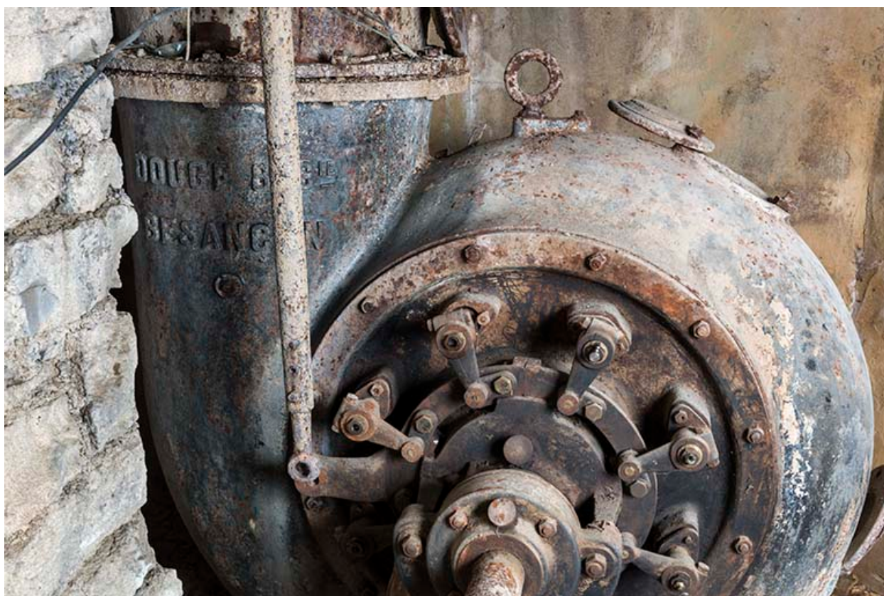
Atelier de fabrication, sciurier : turbine Douge.
