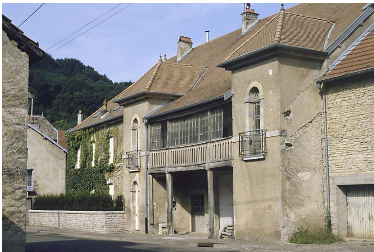
Oiselay-et-Grachaux : maison située 33 Grande rue à Oiselay.
