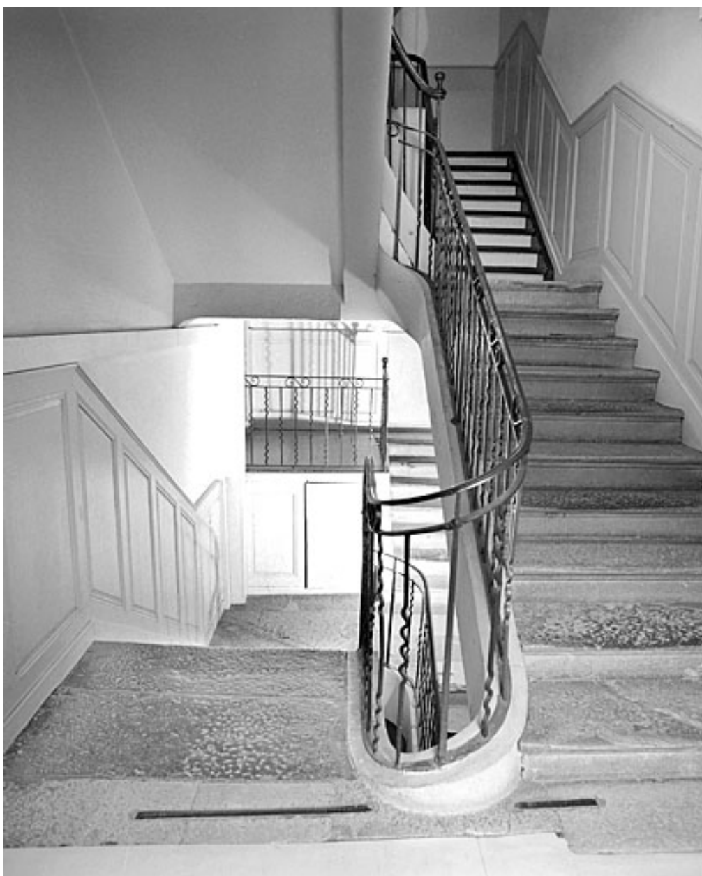
Escalier au deuxième étage.
