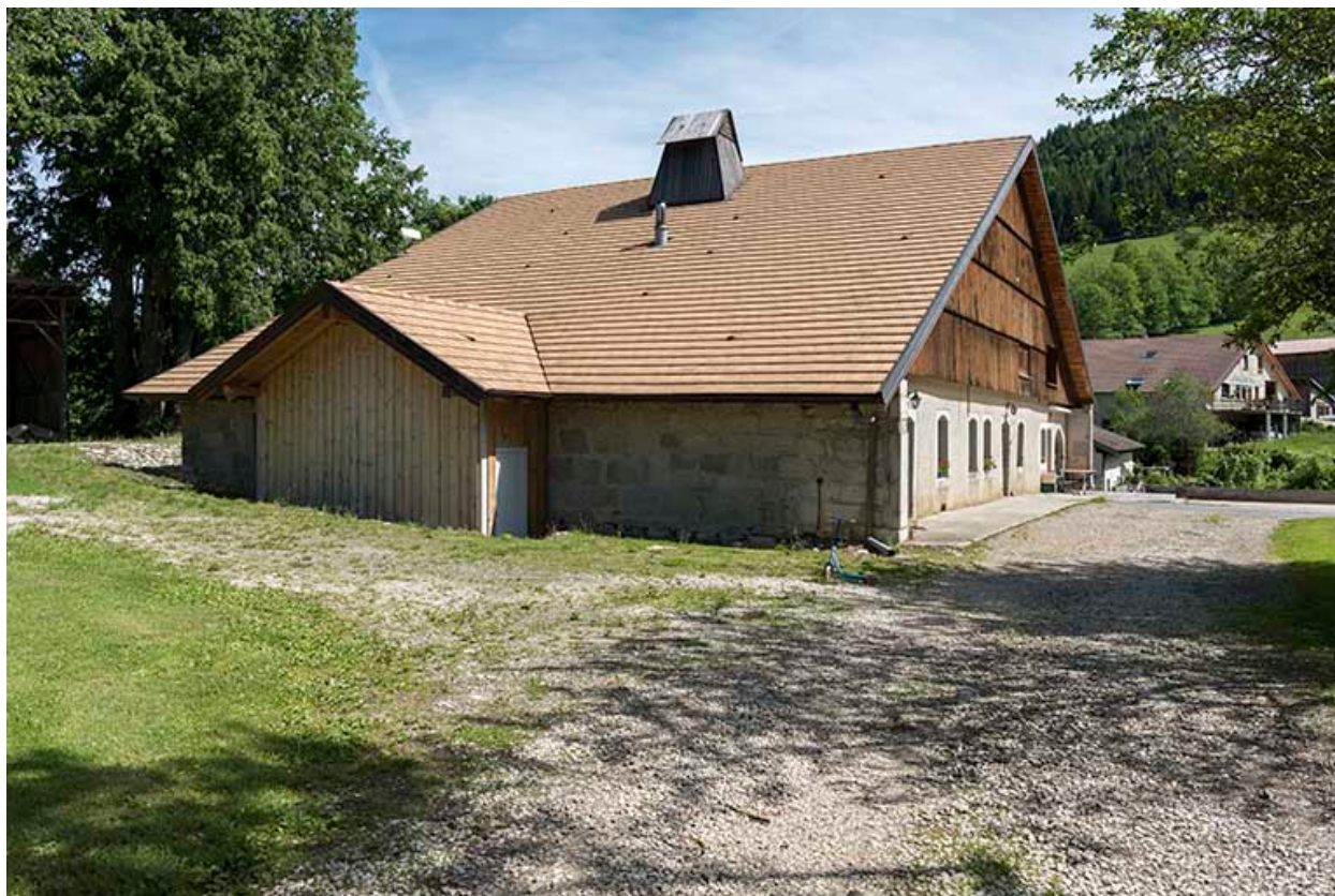
Façades antérieure et latérale gauche.
