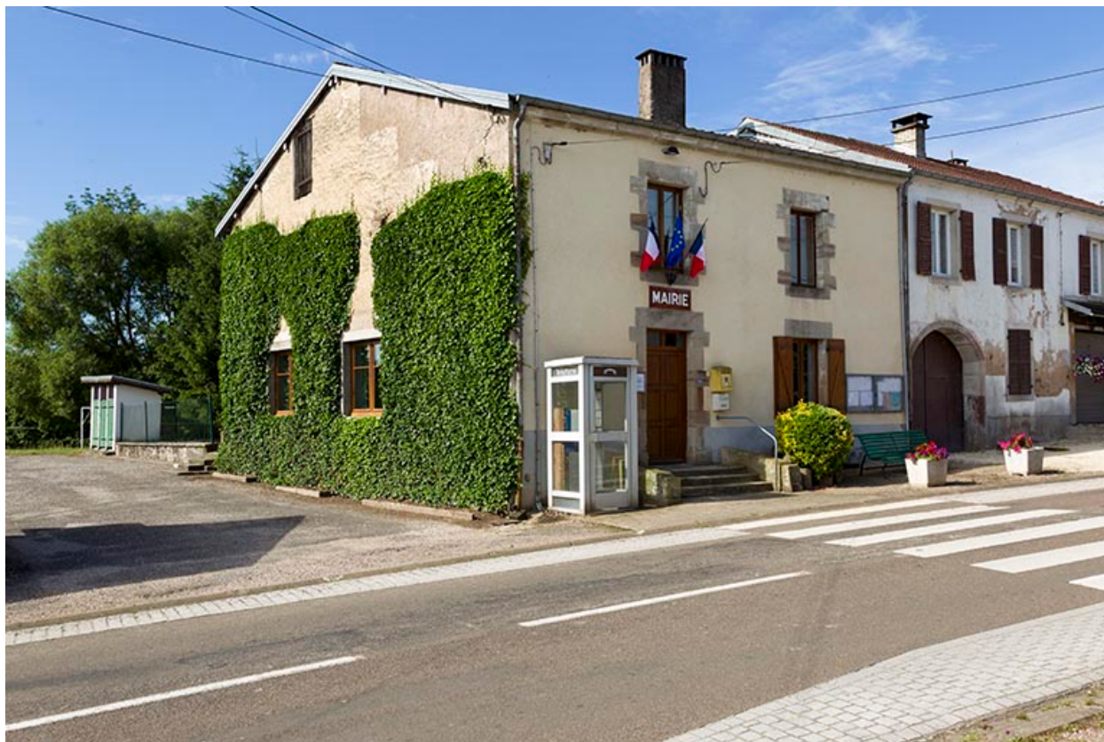
Façades antérieur et latérale gauche.
