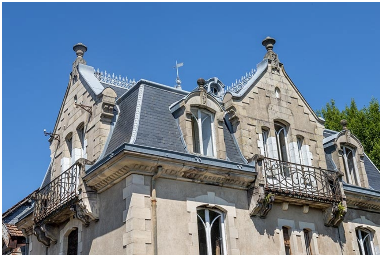
Toiture et lucarnes.
