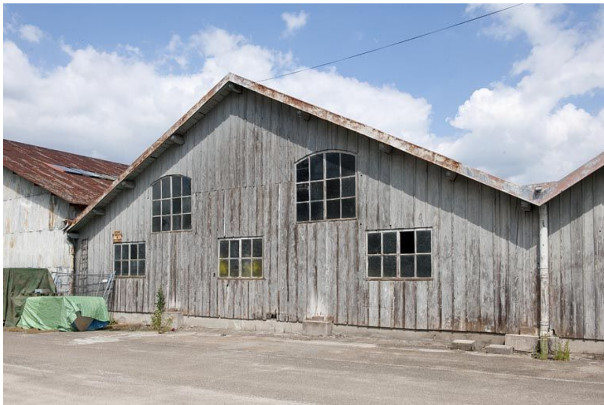
Pignon en bois d'un entrepôt industriel.
