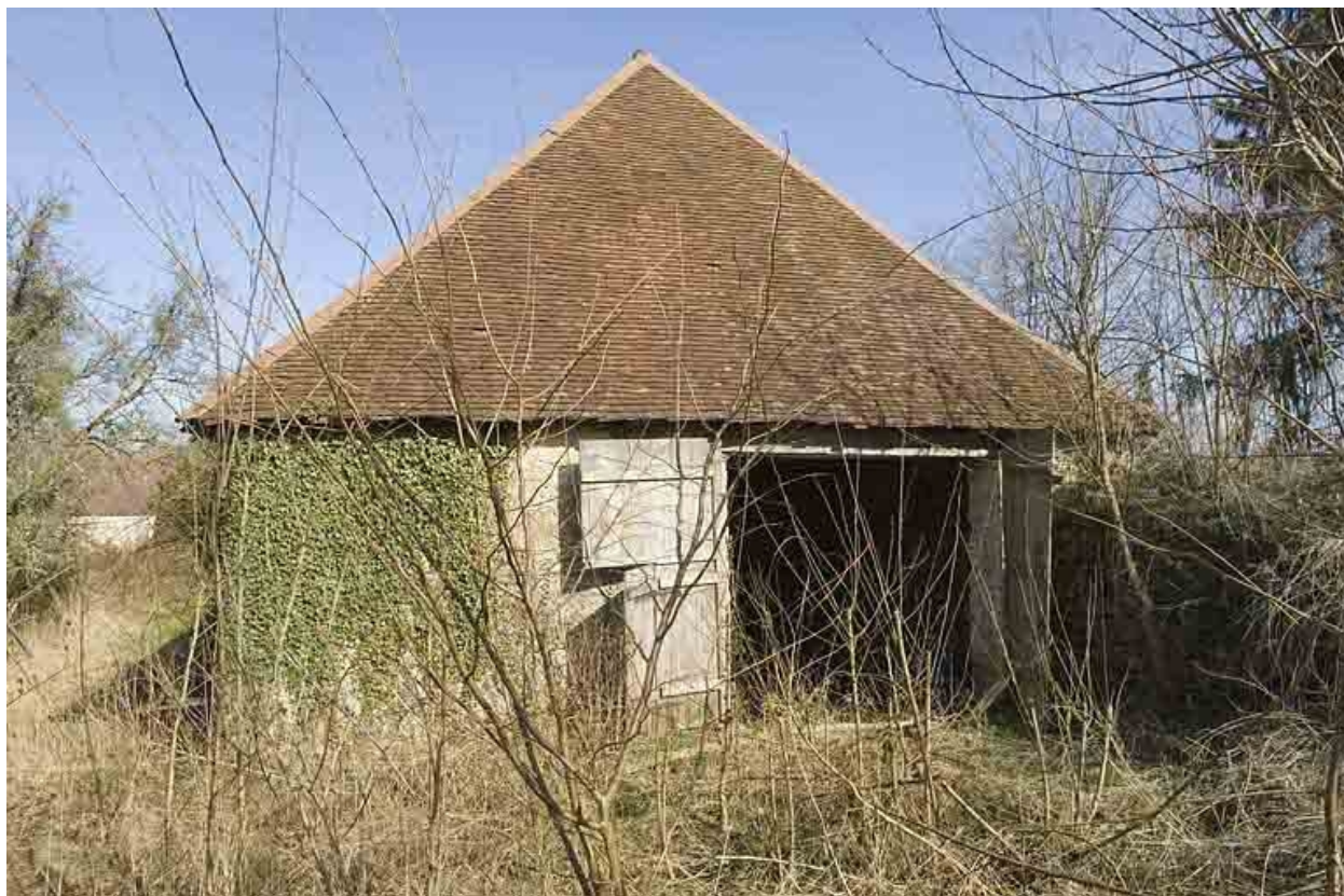
Pignon sud de la halle à charbon.
