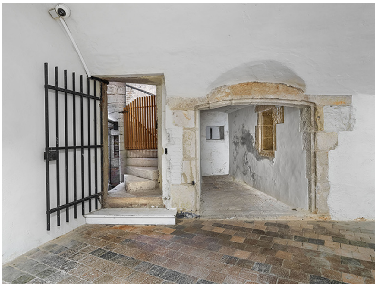
Tour Notre-Dame : porte d'accès au premier niveau.
