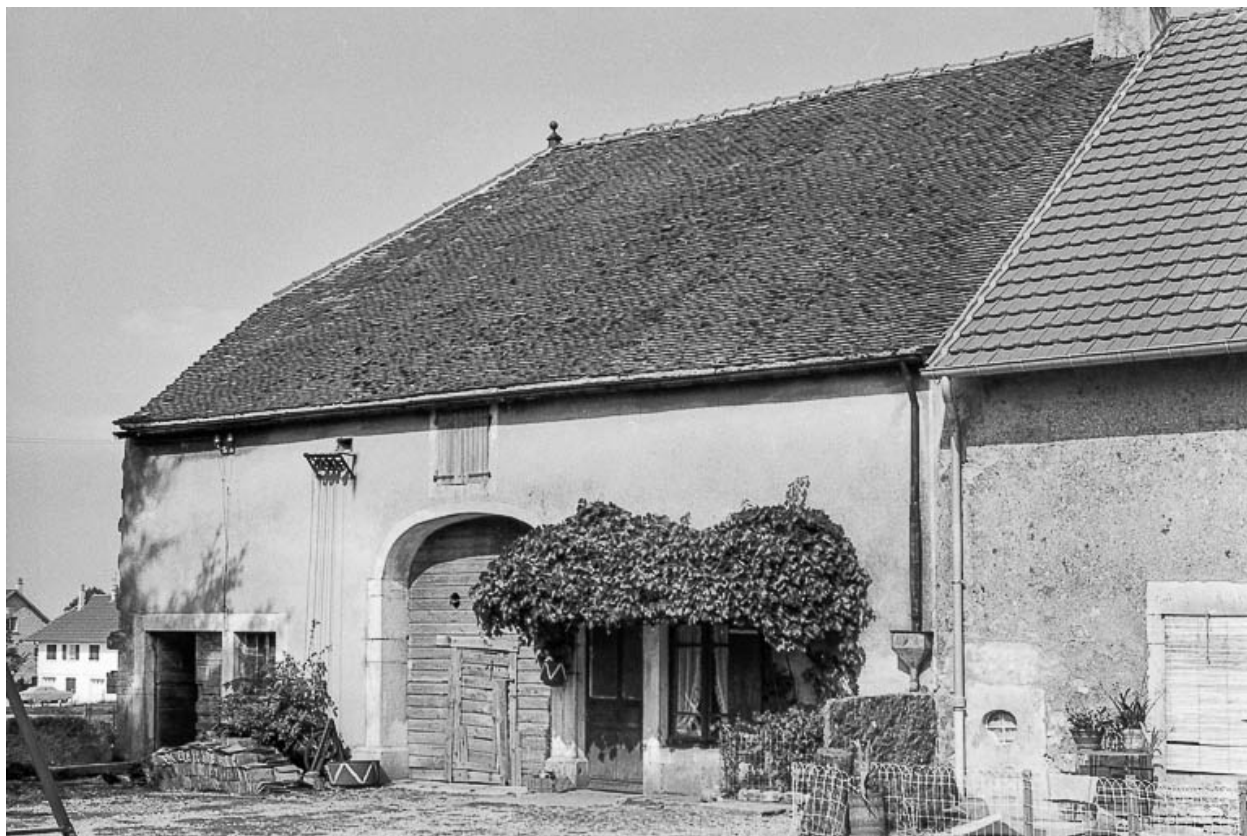
Ferme cadastrée D2 215 : façade antérieure.
