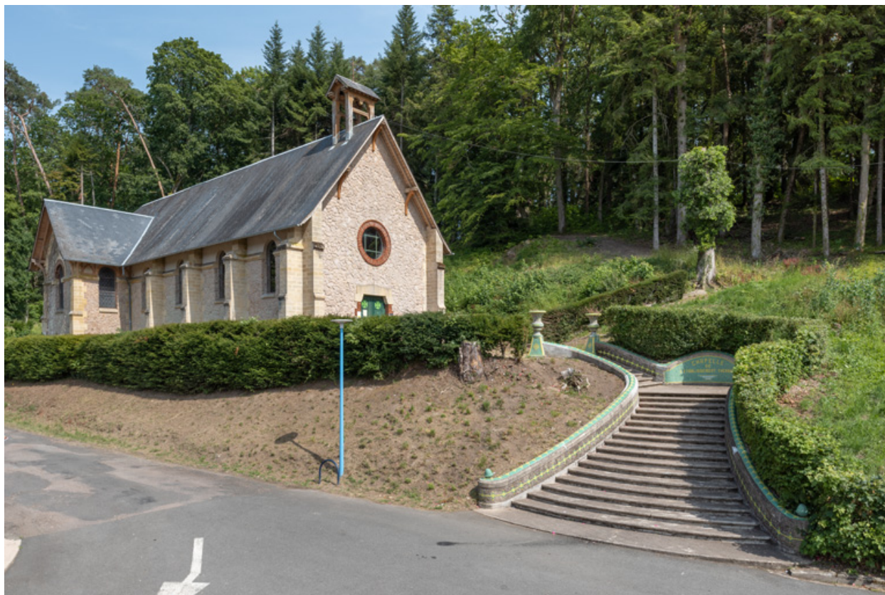
Flanc gauche et façade.
