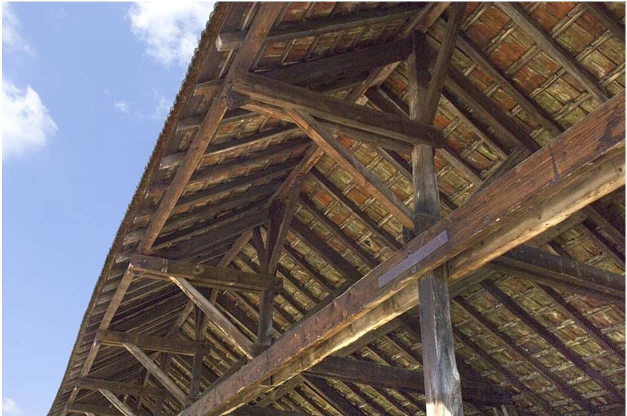
Entrepôt industriel ouest. Détail de la charpente.
