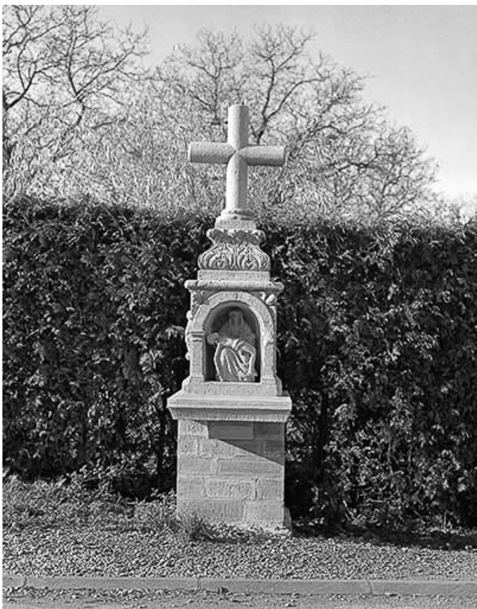
Croix après restauration : de face.
