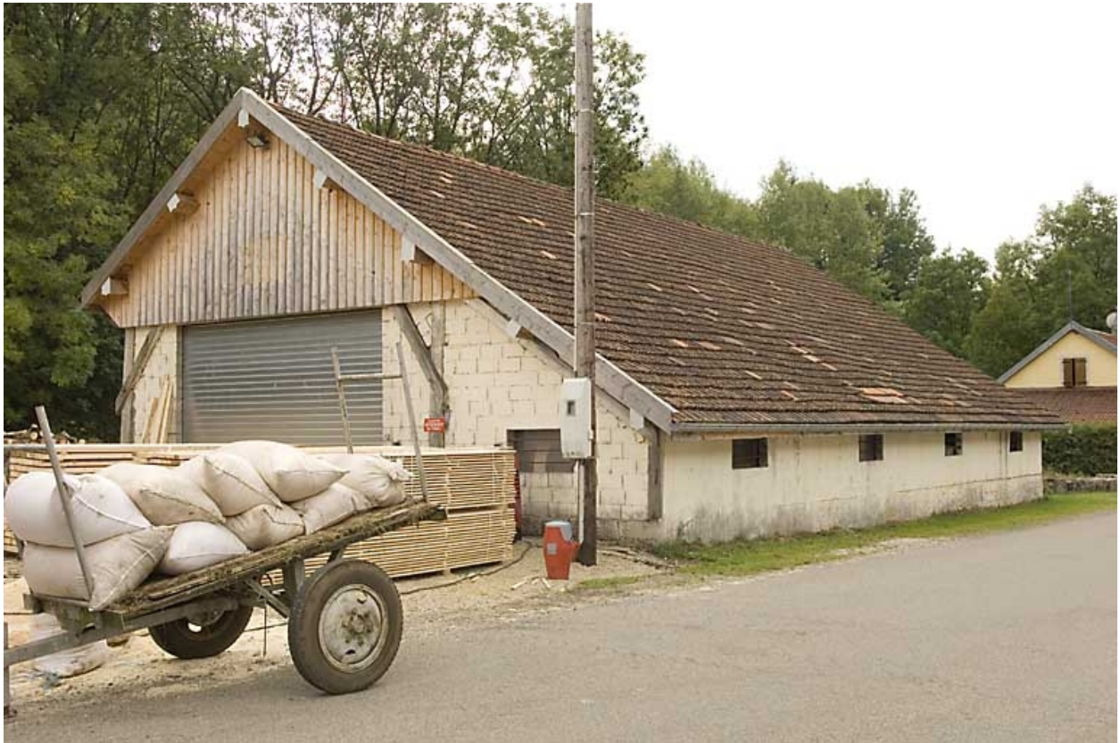
Partie sud : 2e bâtiment.
