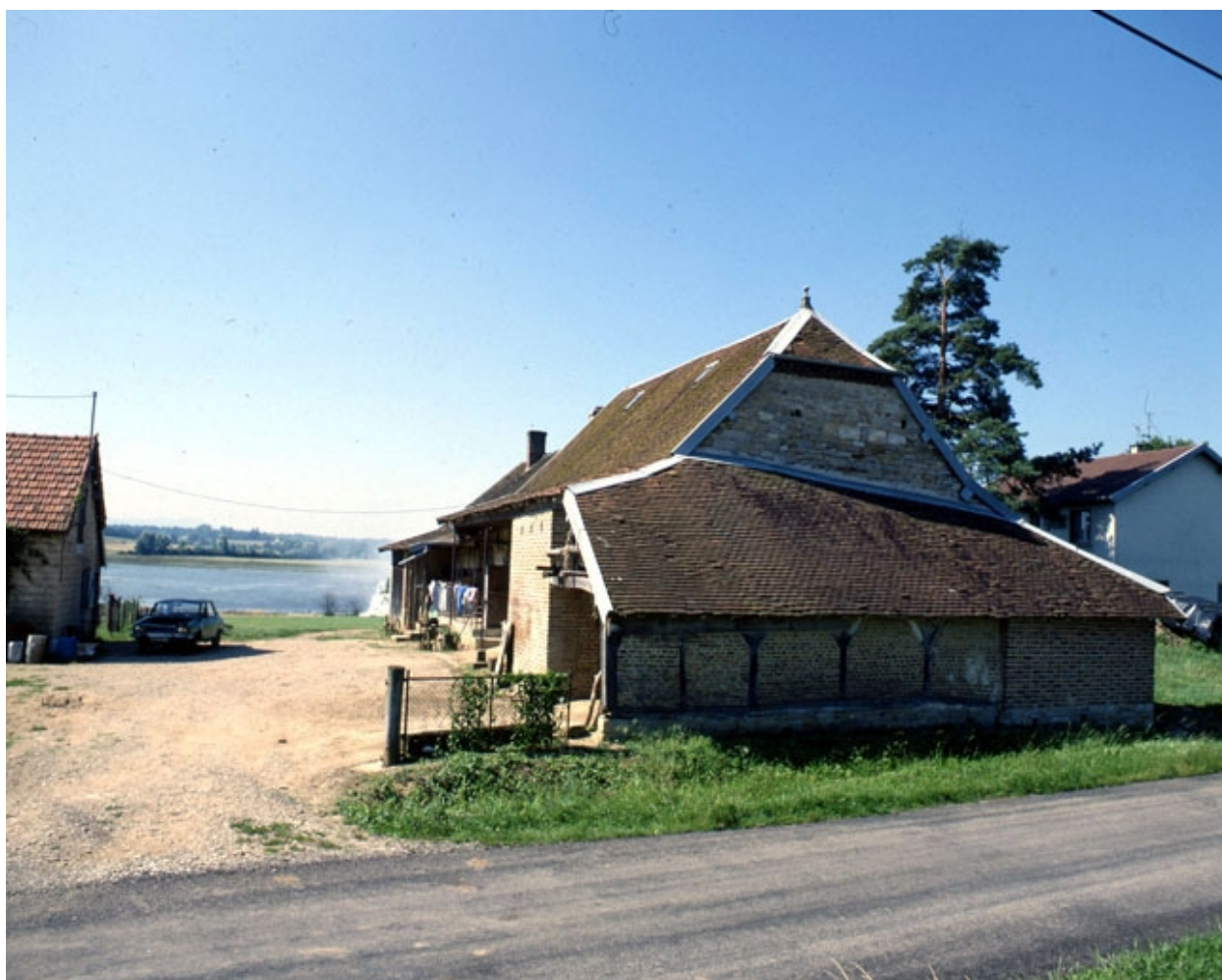
Fontainebrux : ferme située route de Fontainebrux.
