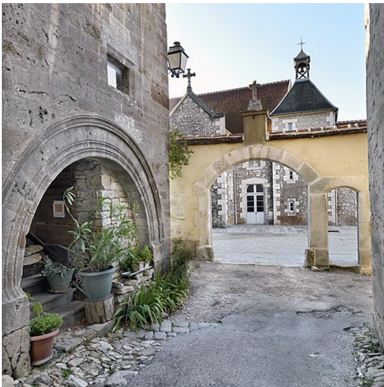
Vue d'ensemble depuis la rue du Couvent.
