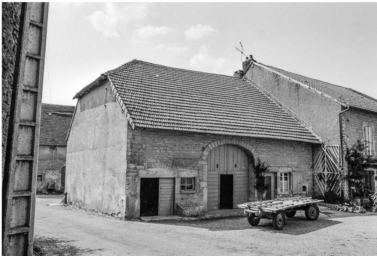
Ferme cadastrée D2 204 : façade antérieure.
