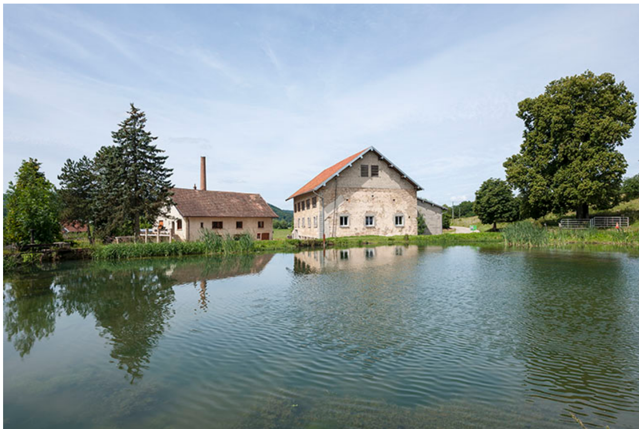
Vue d'ensemble depuis l'étang de retenue.
