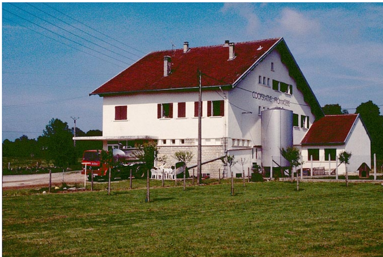
Façades antérieure et latérale droite.
