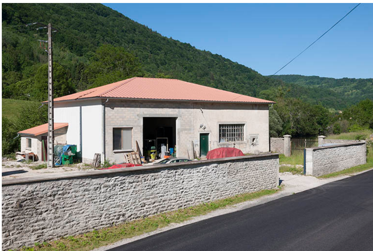
La centrale hydroélectrique.
