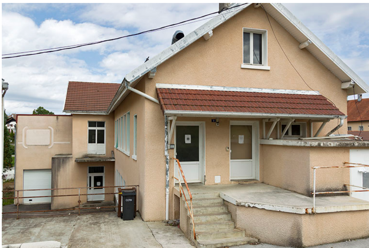
Usine : façade antérieure.
