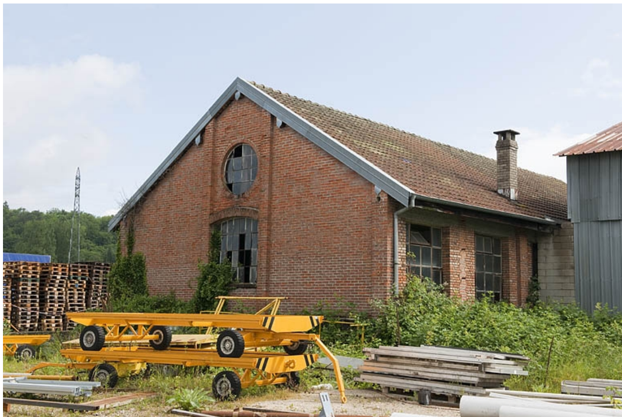
Entrepôt industriel vu de trois quarts arrière.
