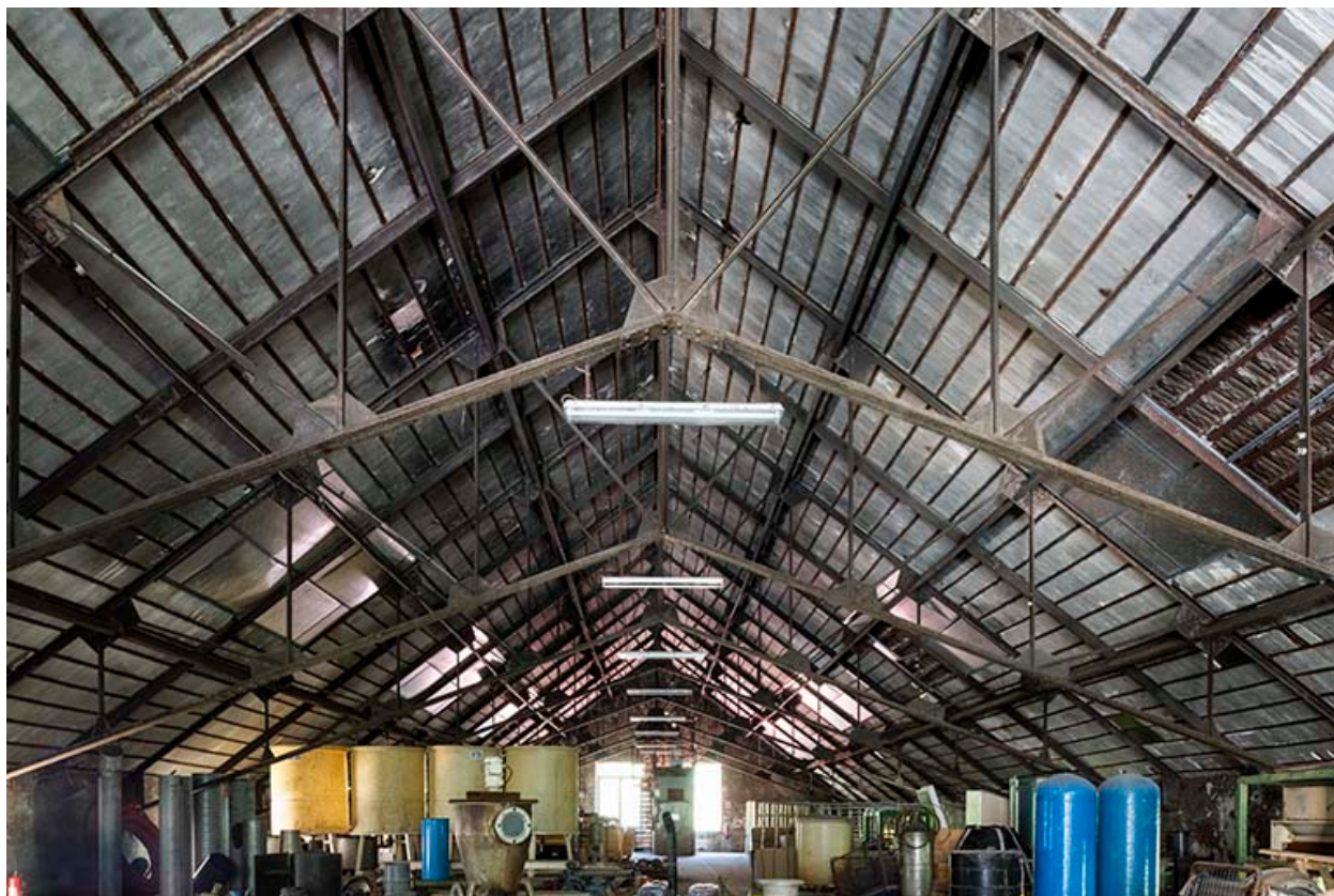
Atelier de fabrication (ancienne tréfilerie) : charpente métallique.
