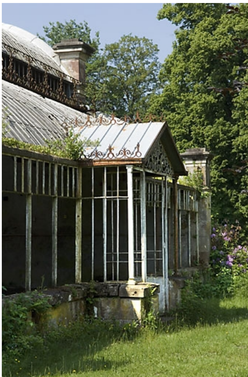
Serre. Détail de la façade nord.
