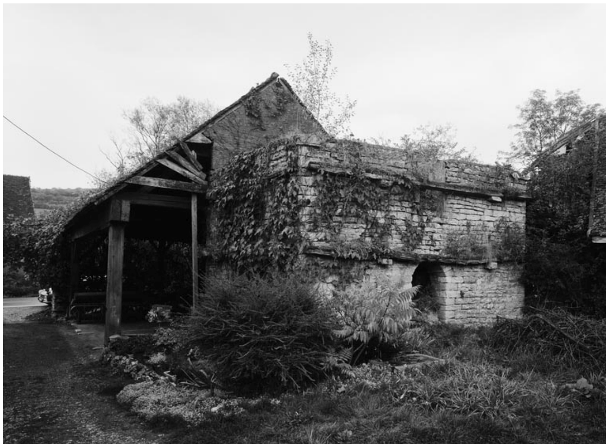
Bâtiment du four et four : élévation postérieure.
