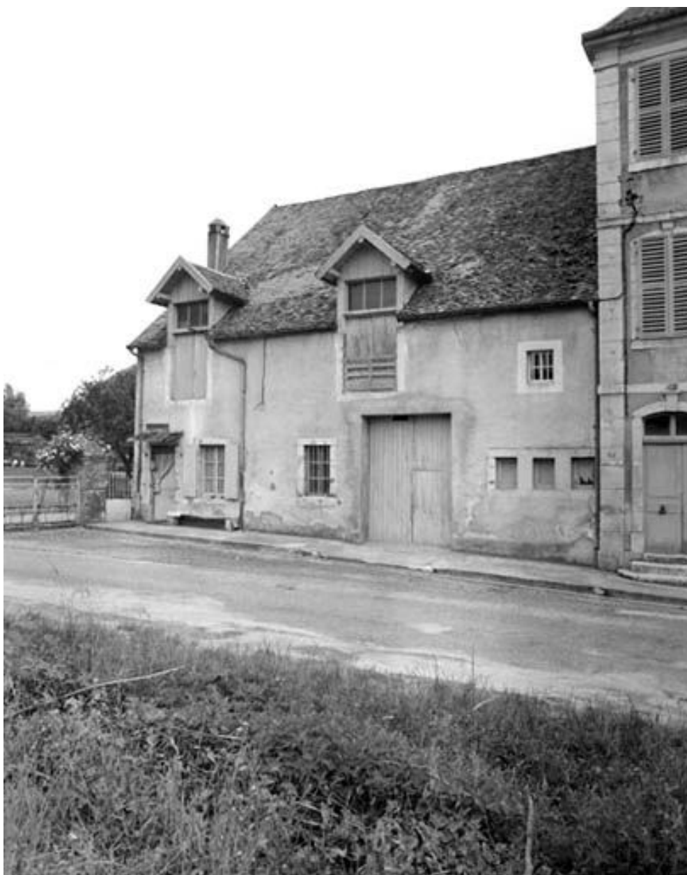
Ferme située 26 rue du Seult.
