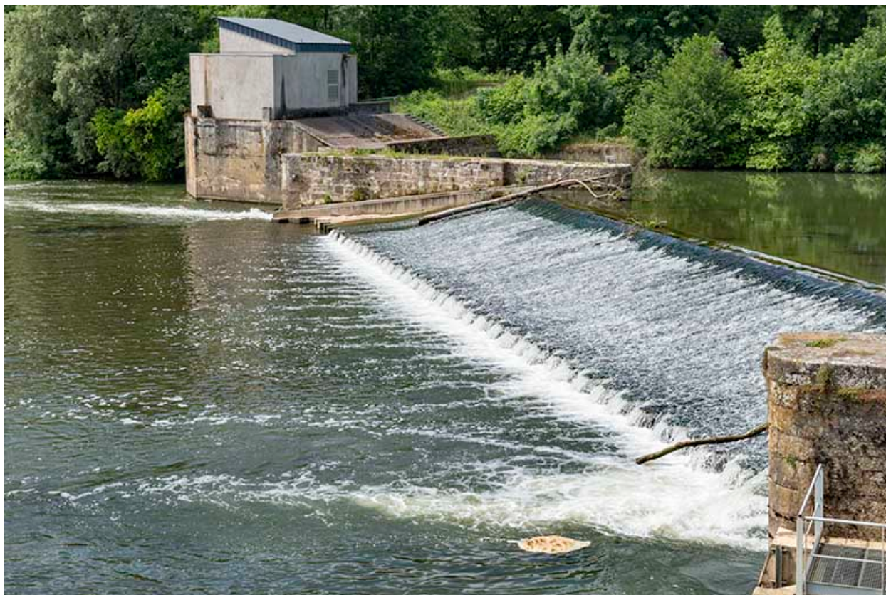
Le déversoir, détail.
