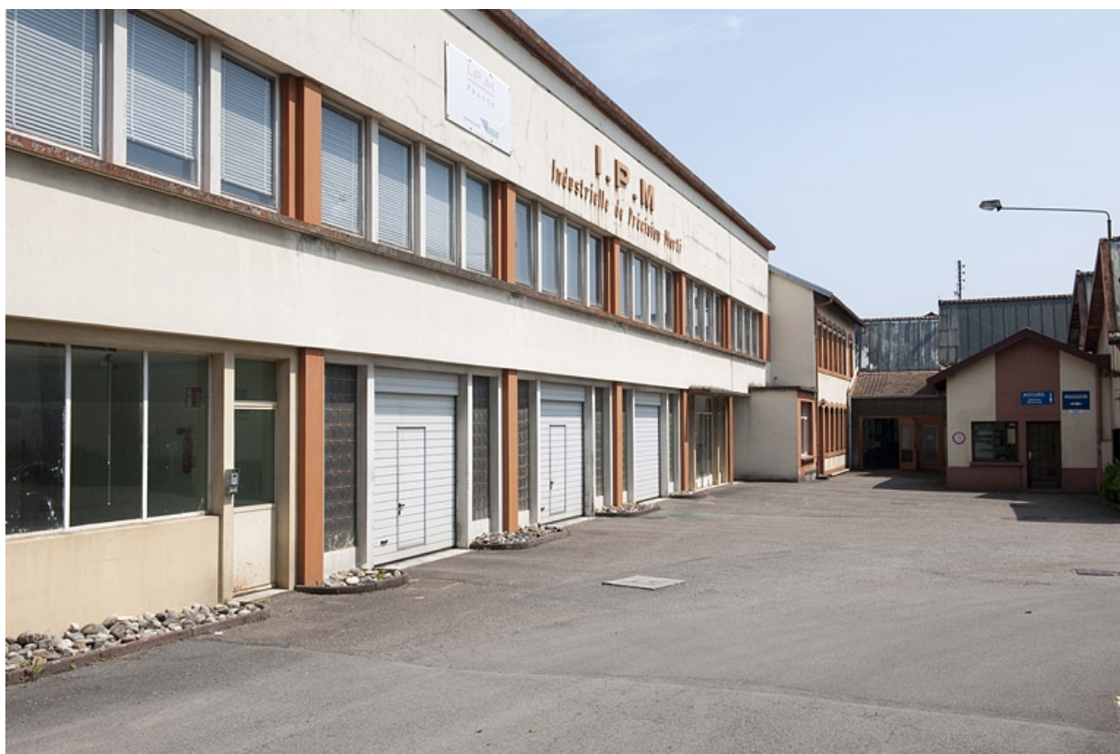
Bâtiments de bureaux vu de trois quarts.
