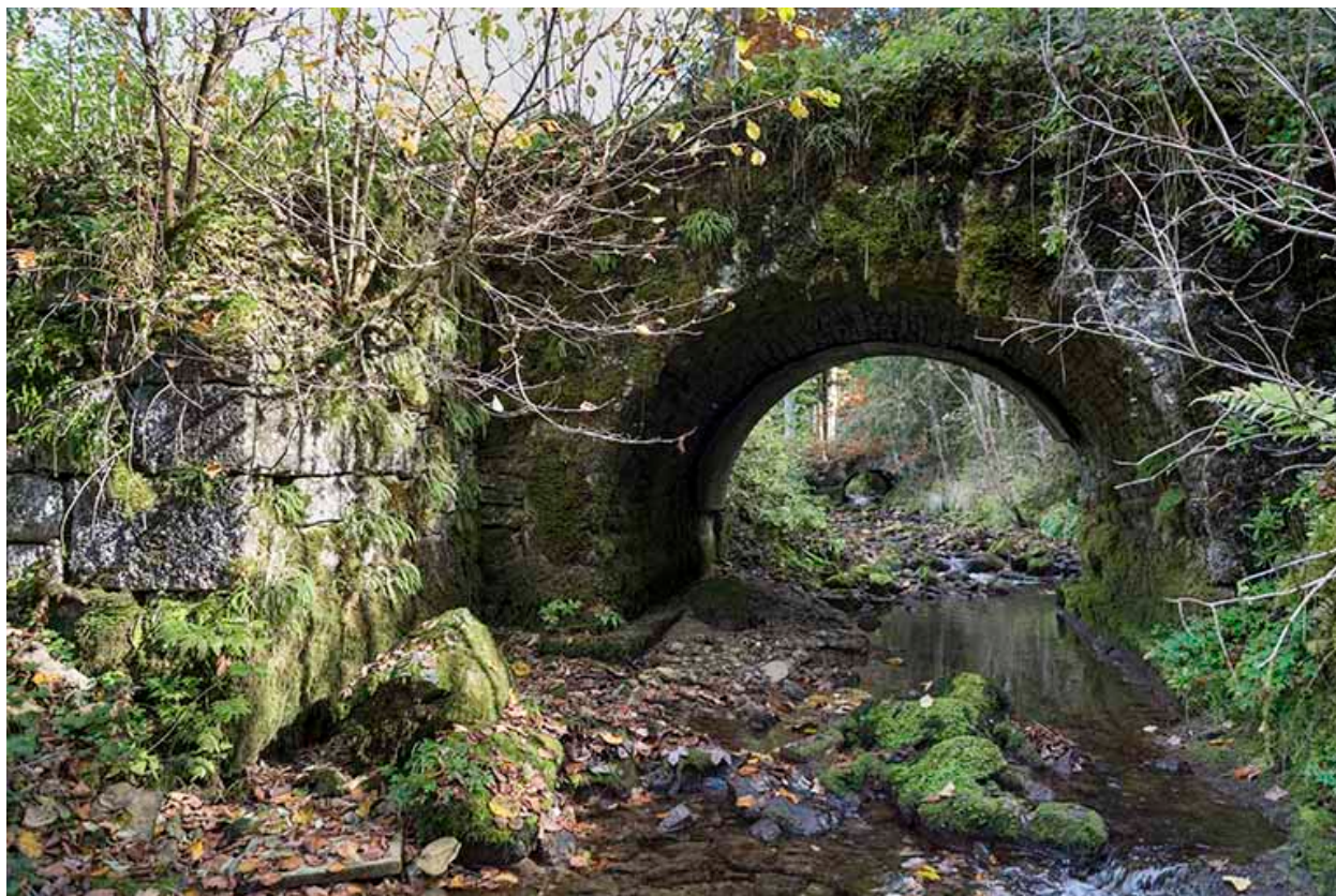
Pont en aval, à l'ouest.
