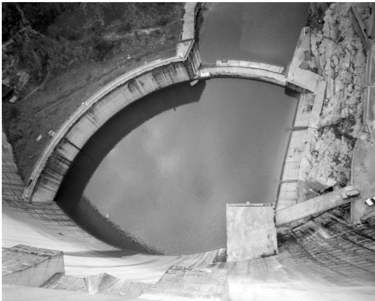
Vue plongeante sur le bassin d'amortissement.
