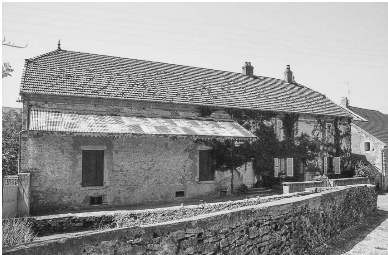
Maison cadastrée 1980 C1 208 : façade antérieure.
