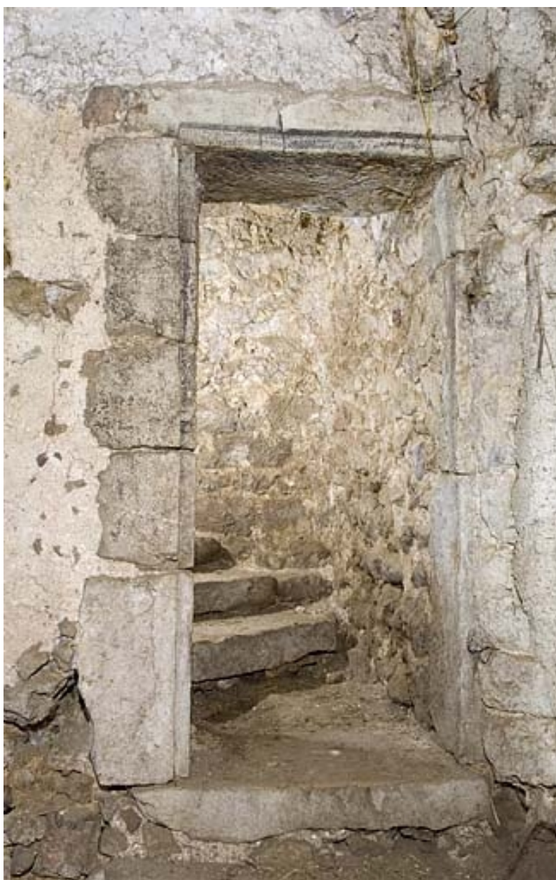
Porte donnant accès à l'escalier en pierre.
