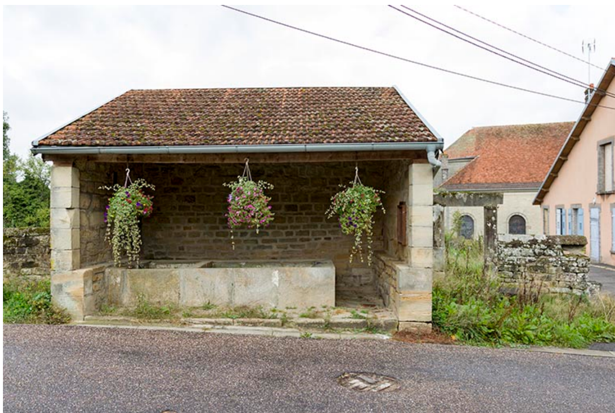
Lavoir, rue du Château.
