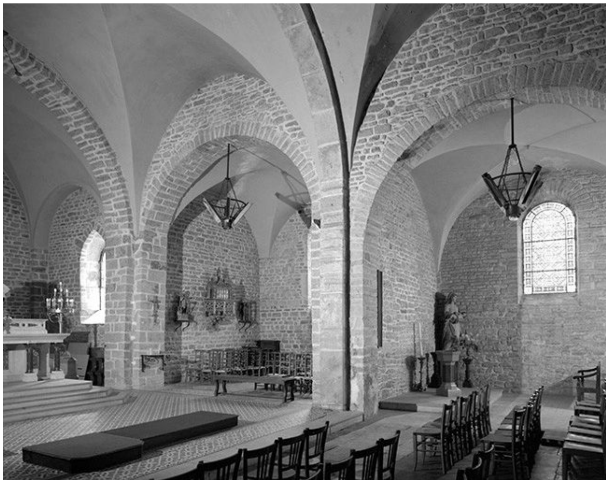
Elévation intérieure droite.
