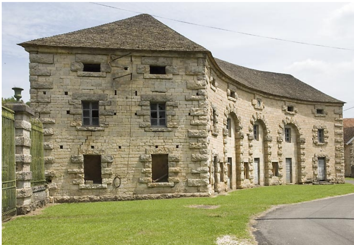
Magasin en quart de cercle depuis le sud-est.
