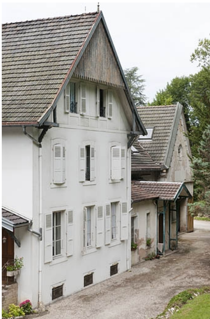
Détail des pignons de la façade postérieure.
