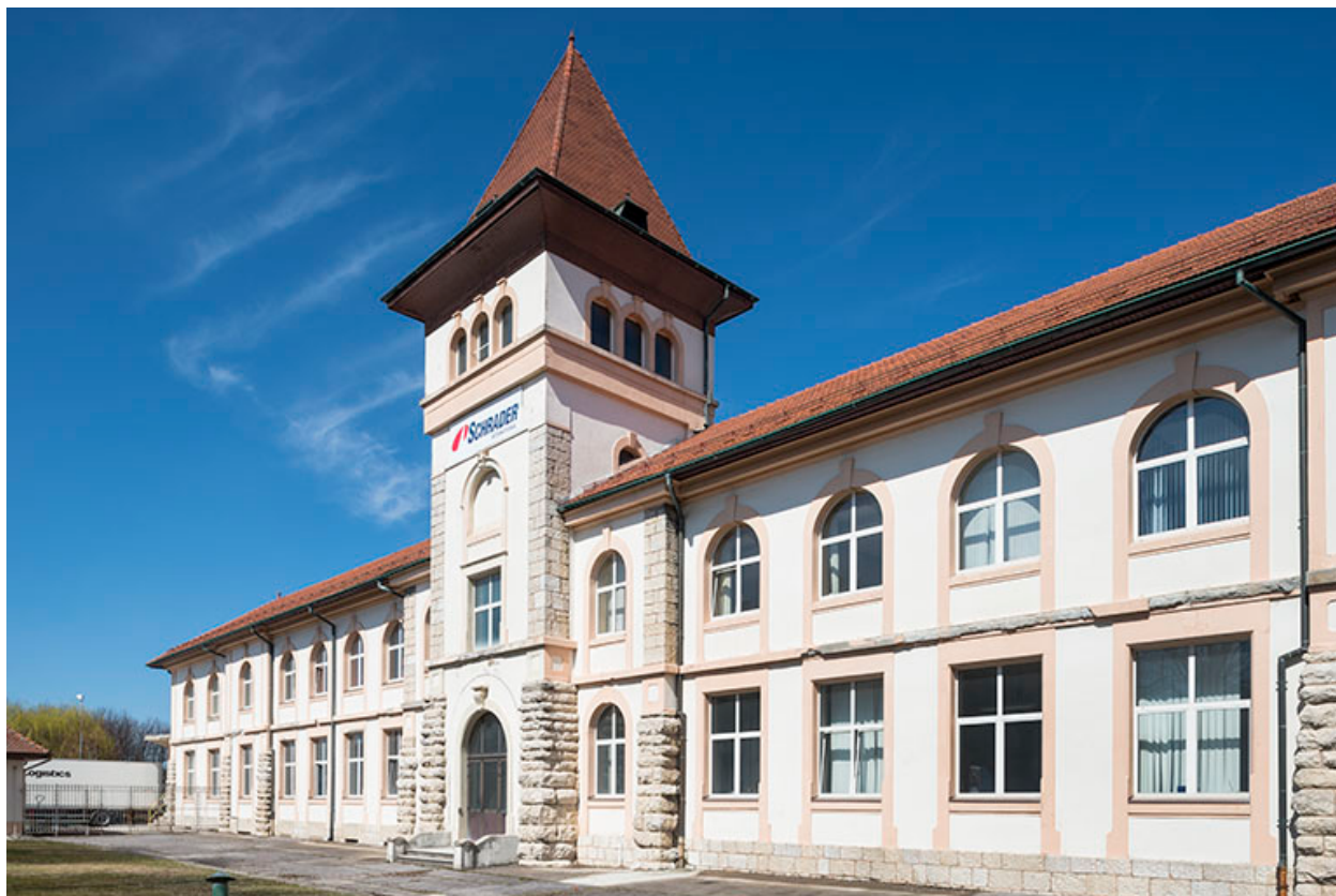
Usine de petite métallurgie Schrader, à Pontarlier.
