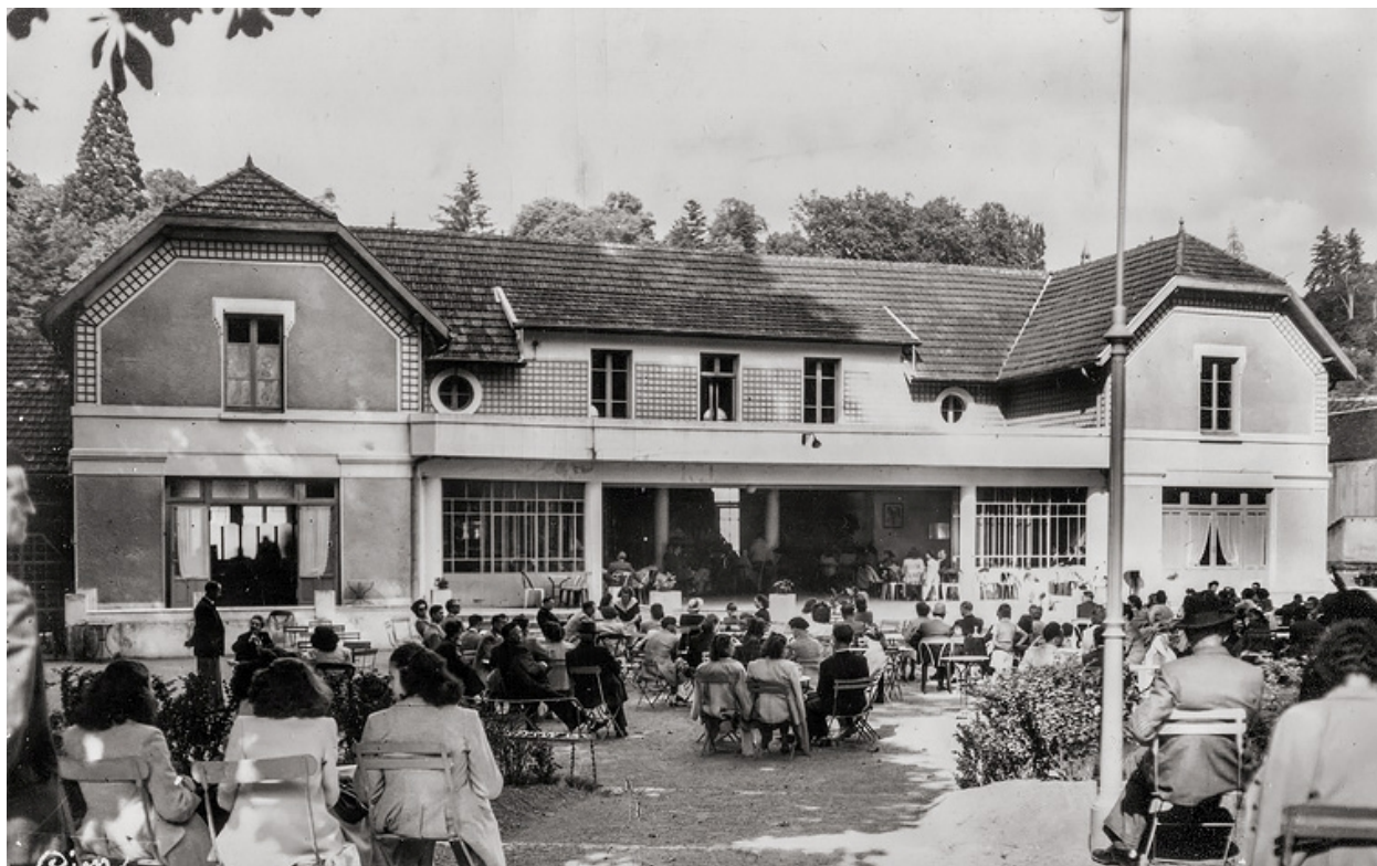
Façade sur le parc.
