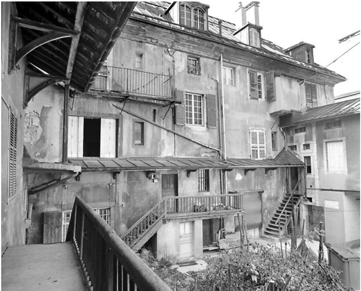
Elévation postérieure, de trois quarts gauche.
