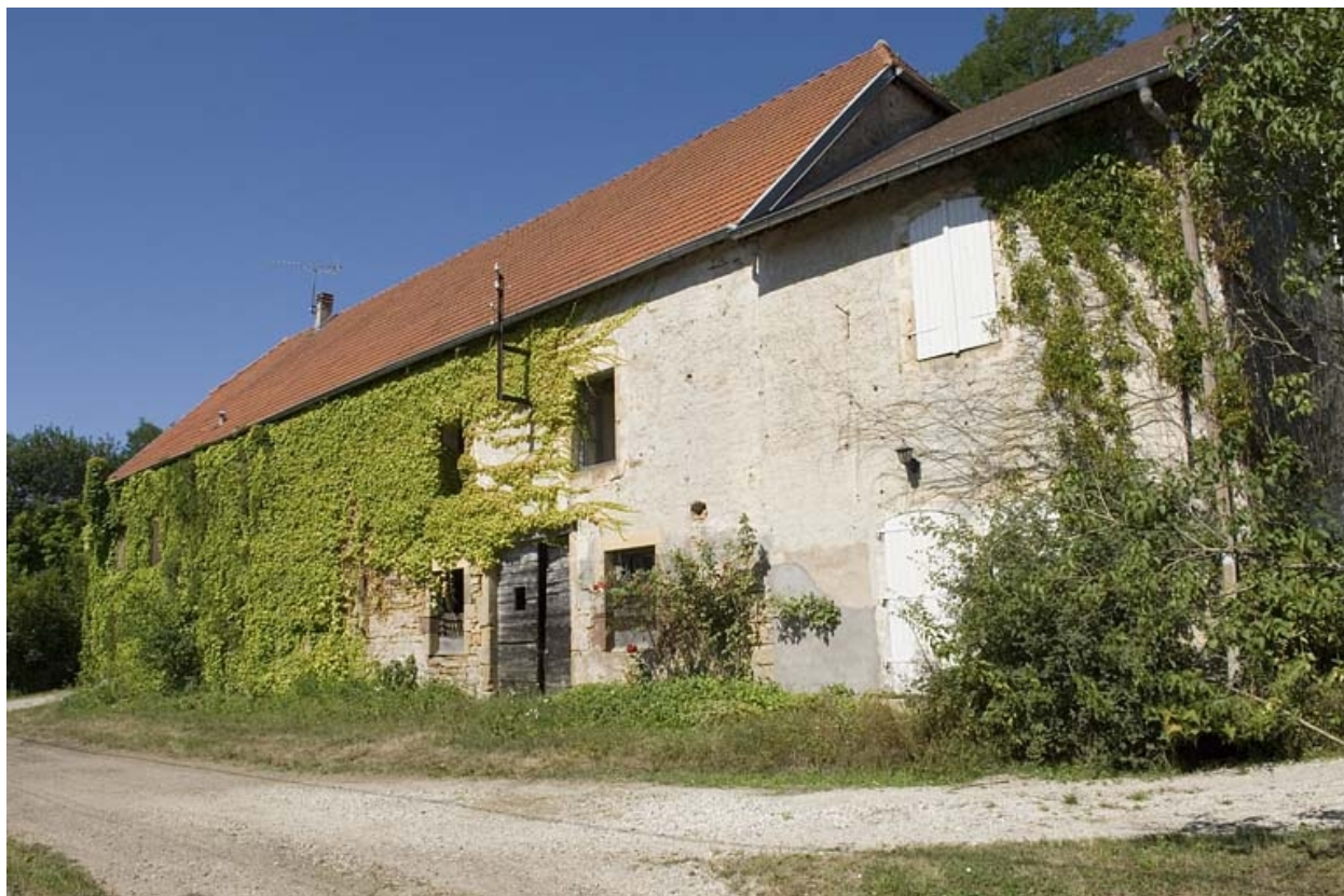
Ancien magasin industriel.
