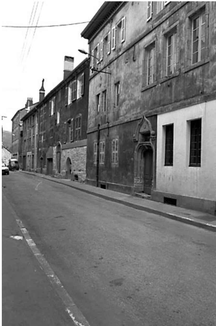
Façade sur la rue Gambetta.
