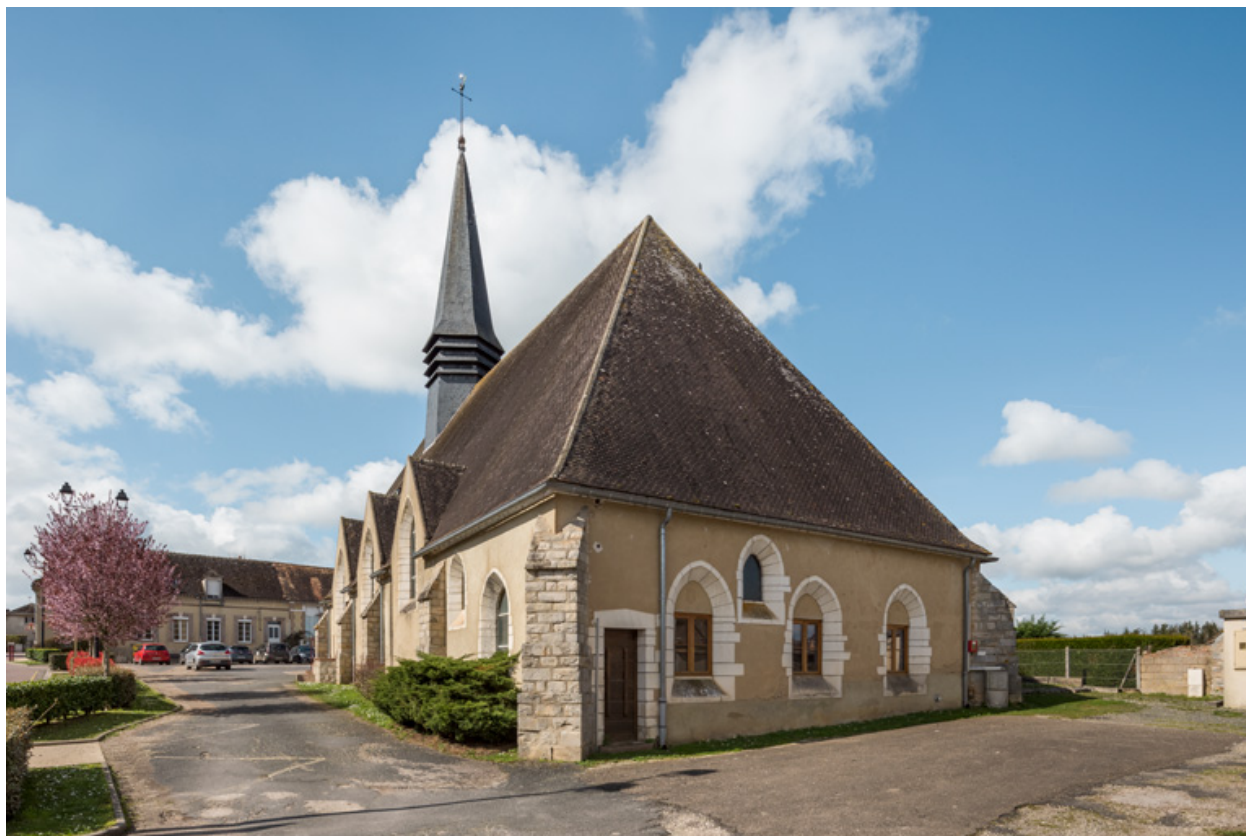
Vue de la sacristie (façade postérieure).
