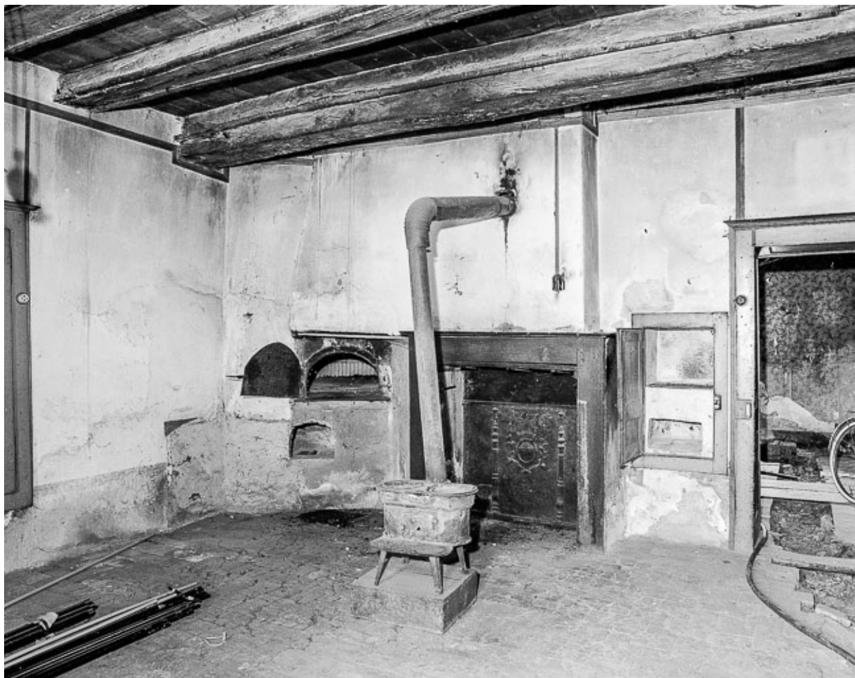
Pièce d'habitation : four, cheminée, cendrier.
