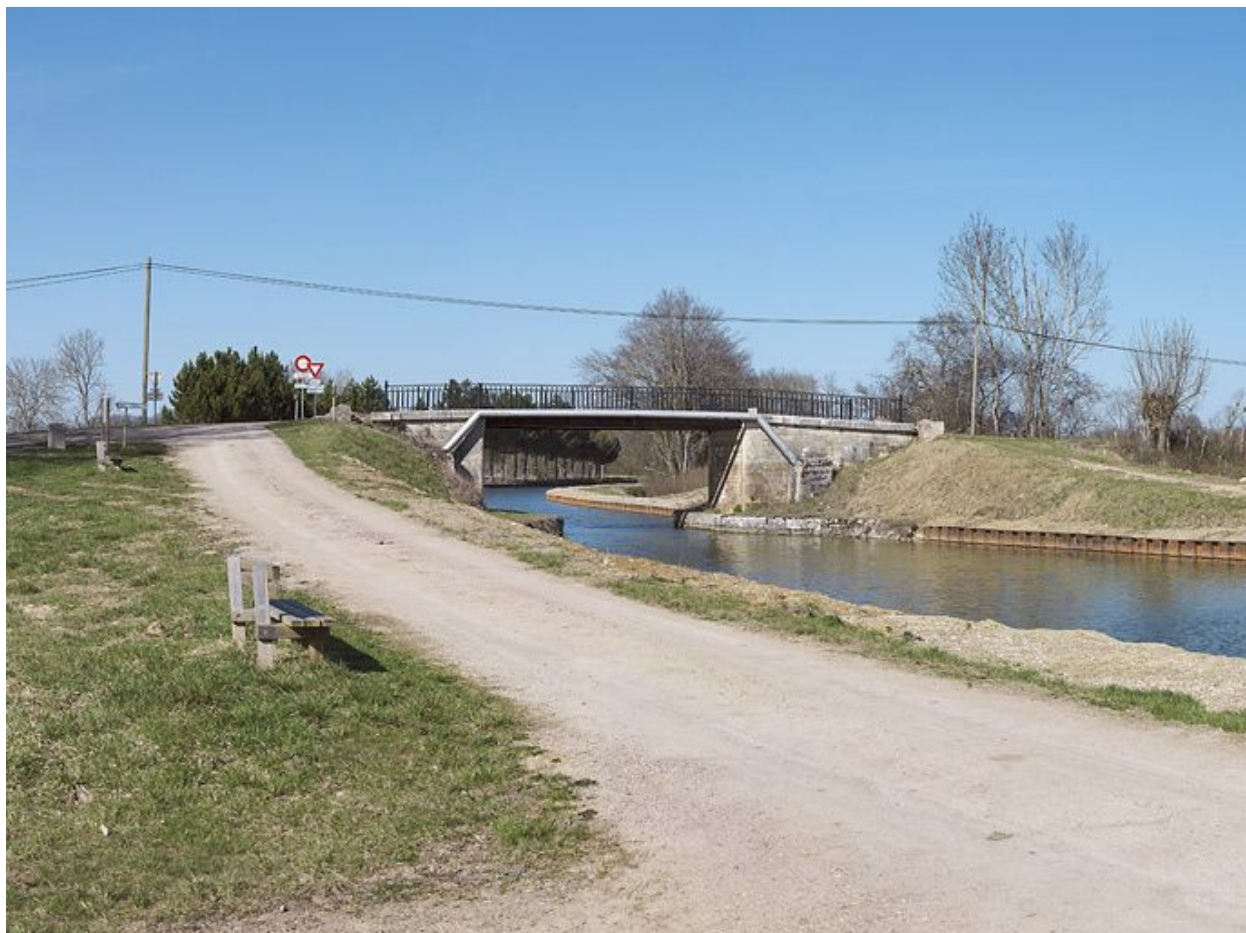
Le pont vu d'amont.
